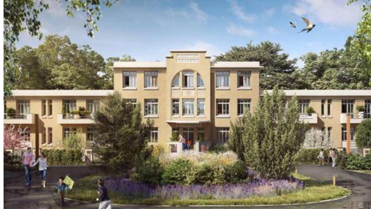
Vue de la façade du Pavillon Pasteur
